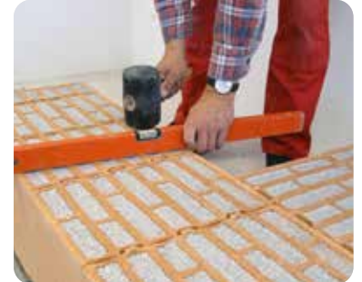
Die 1. Schicht: waagrecht im Mörtelbett ausrichten
