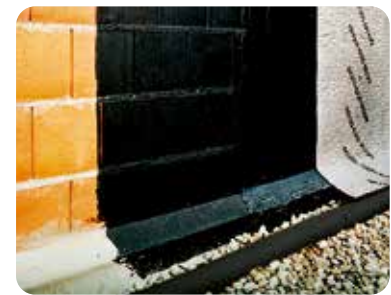
Abdichtung gegen Bodenfeuchte
