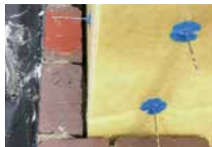
Bild 5 Klemmscheibe mit Abtropfnase als Dämmstoffbefestigung
