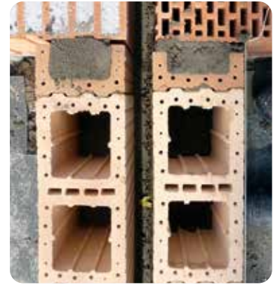
Poroton-Planfüllziegel PFZ-T in der Haustrennwand mit durchgehender Trennfuge
