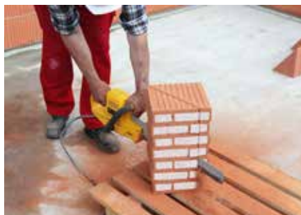
8 Trockenschneiden mit der elektrischen Handsäge.
