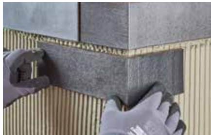
5 Schichtmaß festlegen und mit der Ausbildung der Außenecken unter Verwendung von Winkelriemchen beginnen. (Für die Ausbildung von Läufersturzanten stehen Läuferwinkelriemchen zur Verfügung).
