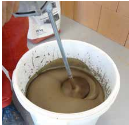
Der Dünnbettmörtel wird idealerweise mit einem leistungsfähigen Rührgerät und Doppelrührquirl klumpenfrei angerührt.
