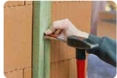
Dübel mit Hammer bündig einschlagen.
