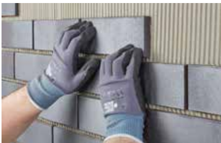
7 Terca Riemchen ansetzen und Ausrichten (für die Arbeitsschritte 4 bis 7 die Hinweise auf Seite 175 beachten).
