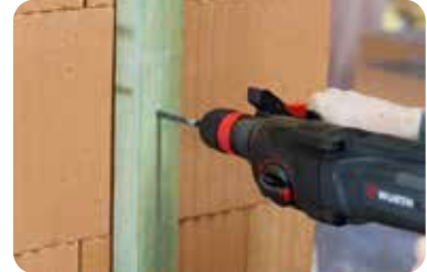
Bohren ohne Schlagfunktion mit scharf angeschliffenem Hartmetallbohrer.
