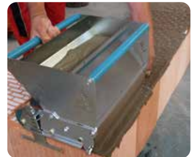
Rollen: Einfaches und rationelles Auftragen des deckelnden Dünnbettmörtels
