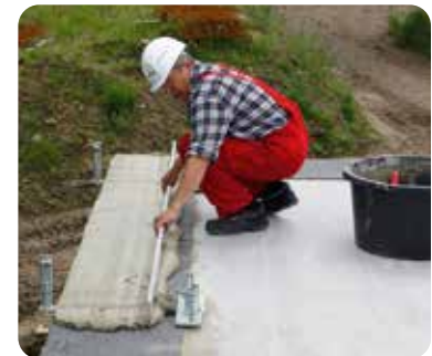
Justierboy: vereinfachtes und exaktes Anlegen der 1. Schicht
