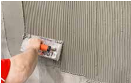
4 Riemchenklebmörtel Terca Flex aufkämmen („Floating“); empfohlene Kammrichtung: vertikal.
