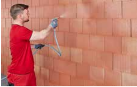
1 Poroton-Mauerwerk vornässen.
