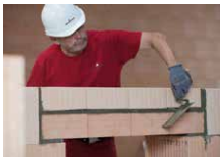
5 Gleiche Vorgehensweise gilt sinngemäß auch beim Einsatz als Höhenausgleich, z. B. im Sturzbereich des Mauerwerks. Bei Einhaltung der vorgenannten Hinweise tragen Höhenausgleichsziegel zur fachgerechten Verarbeitung von homogenem Planziegelmauerwerk bei.
