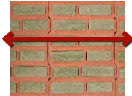
Beispiel verfüllte Wärmedämmziegel
