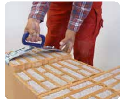
Setzen: Ziegel einfach in die Verzahnung des Nachbarziegels setzen Tragehilfen: machen das Setzen bequemer
