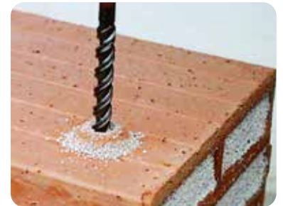
Drehbohren ohne Schlag und Hammerwerk!
