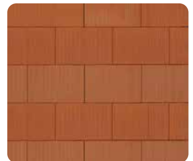
Fertig: sauberes, fast fugenloses Mauerwerk
