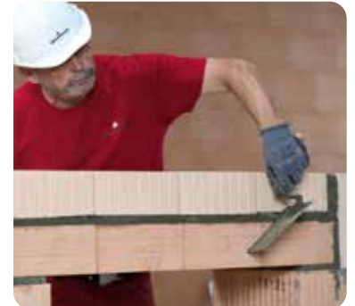
Höhenausgleichsziegel im Sturzbereich.
