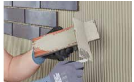
6 Rückseite der Terca Riemchen bzw. Winkelriemchen vor dem Ansetzen mit dem Riemchenklebmörtel Terca Flex dünn bestreichen („Buttering“).
