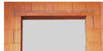
Übermauerung Ziegel-Flachsturz
