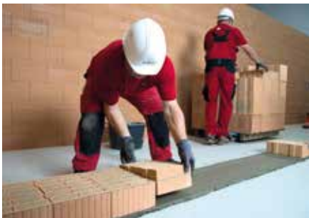
4 Nur so entsteht nach dem Abschnüren und Ausrichten der HAZ eine plangeschliffene Lagerfläche für die weitere Verarbeitung der nachfolgenden Mauerwerksschichten mit Poroton-Dünnbettmörtel.
