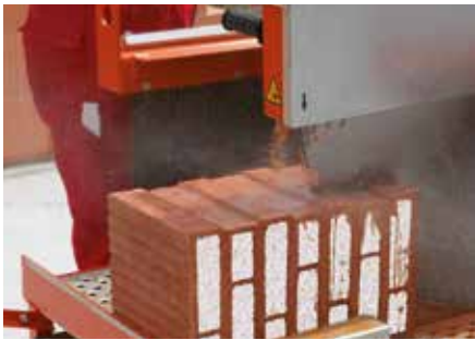
1 Höhenausgleich: Ausgleichsziegel mit der Nasssäge oder trocken mit der Bandsäge schneiden.
