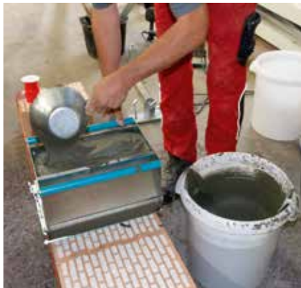
Der angerührte Dünnbettmörtel wird in die Mörtelrolle gefüllt. Vor Beginn der Arbeiten Mörtelrolle mit Trennmittel einsprühen! Erleichtert die spätere Reinigung.
