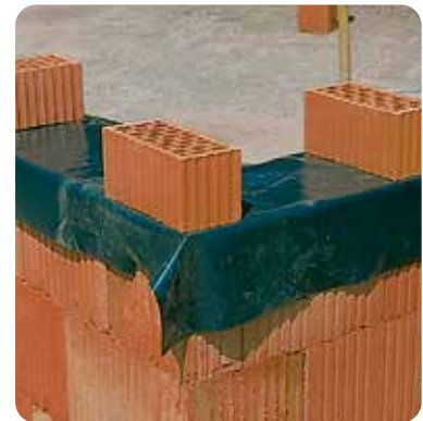
Abdeckung der Mauerkronen
