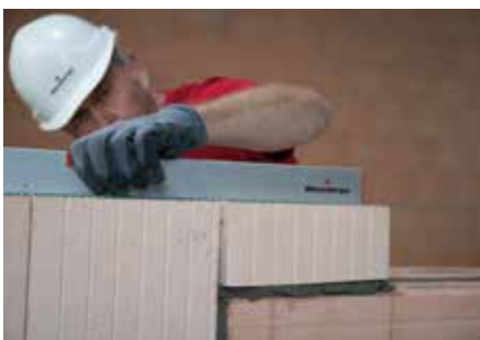
5 Gleiche Vorgehensweise gilt sinngemäß auch beim Einsatz als Höhenausgleich, z. B. im Sturzbereich des Mauerwerks. Bei Einhaltung der vorgenannten Hinweise tragen Höhenausgleichsziegel zur fachgerechten Verarbeitung von homogenem Planziegelmauerwerk bei.
