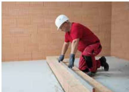
4 Nur so entsteht nach dem Abschnüren und Ausrichten der HAZ eine plangeschliffene Lagerfläche für die weitere Verarbeitung der nachfolgenden Mauerwerksschichten mit Poroton-Dünnbettmörtel.
