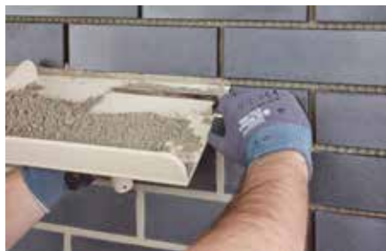
8 Kellenfugenmörtel Terca Solid mit Fugenkelle einbringen, verdichten und glattstreichen (Hinweise auf Seite 181 bis 182 beachten).
