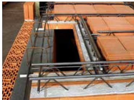
Kurvenschnitt Deckenziegel
