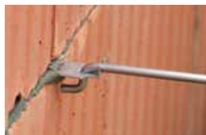
Bild 3 Luftschichtanker gibt es in verschiedenen Längen
