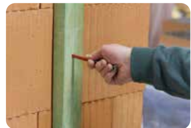
Dübel (ggf. bereits mit Schraube) ansetzen.
