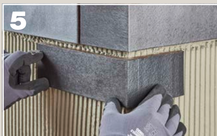
5 Schichtmaß festlegen und mit der Ausbildung der Außenecken unter Verwendung von Winkelriemchen beginnen. (Für die Ausbildung von Läufersturzkannten stehen Läuferwinkelriemchen zur Verfügung).
