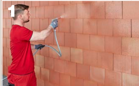
1 Poroton-Mauerwerk vornässen.
