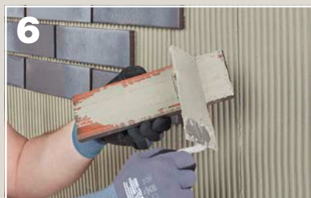
6 Rückseite der Terca Riemchen bzw. Winkelriemchen vor dem Ansetzen mit dem Riemchenklebmörtel Terca Flex dünn bestreichen („Buttering“).
