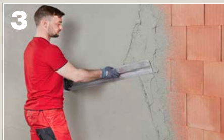
3 Nivelliermörtel Poroton Base eben verziehen (für die Arbeitsschritte 1 bis 3 die Hinweise auf Seite 12 beachten).
