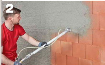
2 Nivelliermörtel Poroton Base aufspritzen oder mit der Kelle auftragen.
